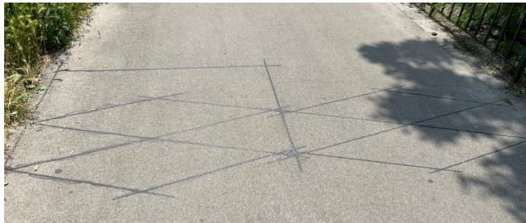
Abb. 3.3: Induktionsschleife
