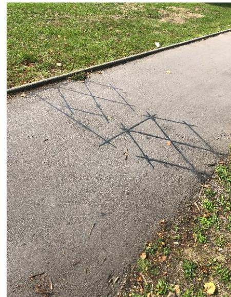
Abb. 1 Induktionsschleifen
