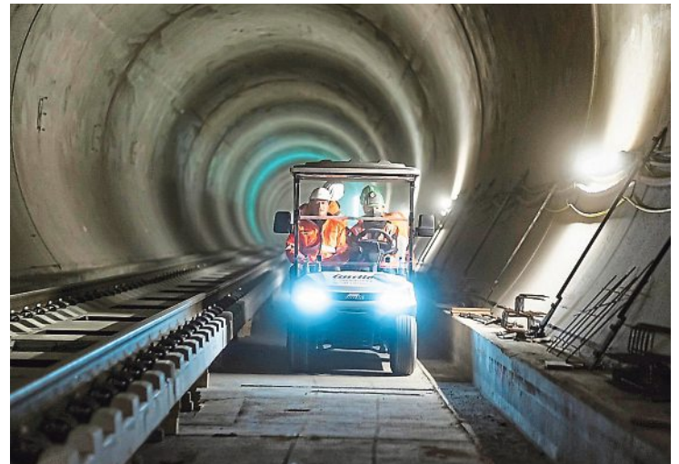
Beim Tunnelbau haben die Mineure Großartiges geleistet.
