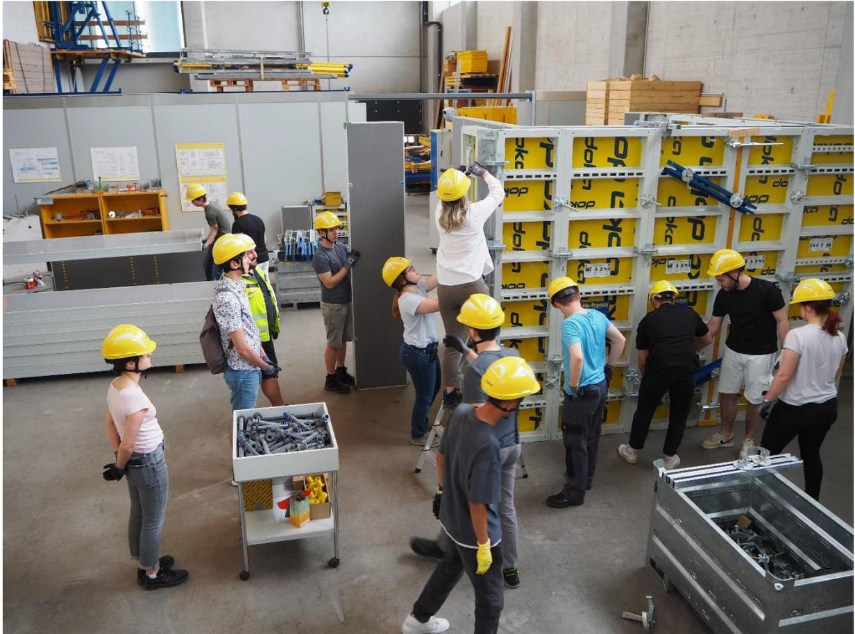
Abbildung 4: Die Gruppe beim Befestigen der Schalungsplatten mit Spannklemmen
