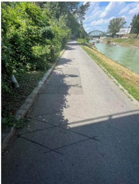
**Abb. 2:** Schleifenpaare
