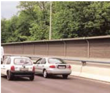
Bogenelemente bei Prater Hochstraße, Wien
