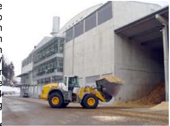
Illustration 7: Blick auf Hauptgebäude, Bagger
