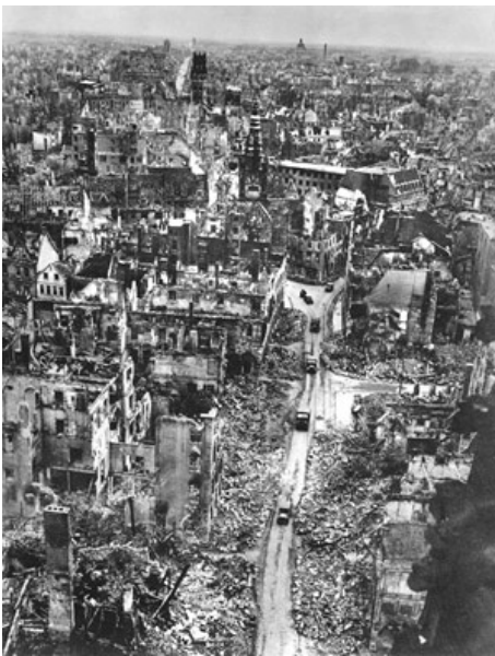
Abbildung 9: Blick von der Lambertikirche auf den zerstörten Prinzipalmarkt
