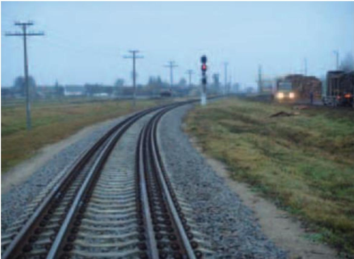
**Abb. 13:** Vierschienengleis mit russischer Breitspur und Normalspur [Murach & Roß, 2012, S. 420]
