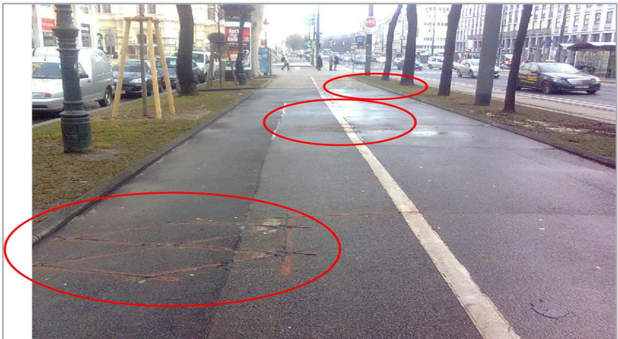
**Abb. 4:** Lage der Induktionsschleifen am Opernring Innen
