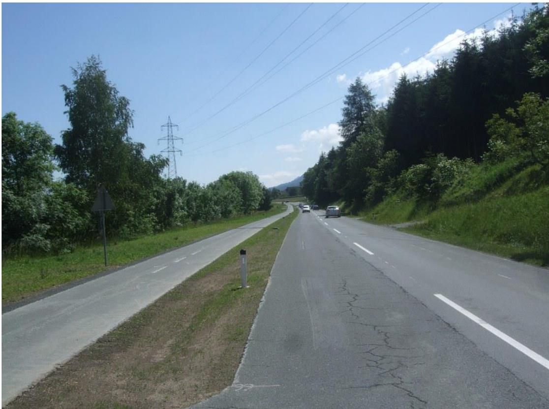
**Abb. 7:** B83 bei Arnoldstein nach der Querschnittsanpassung; Foto: Kärntner Landesregierung, Abt. 9 (04.06.2014) [19]
