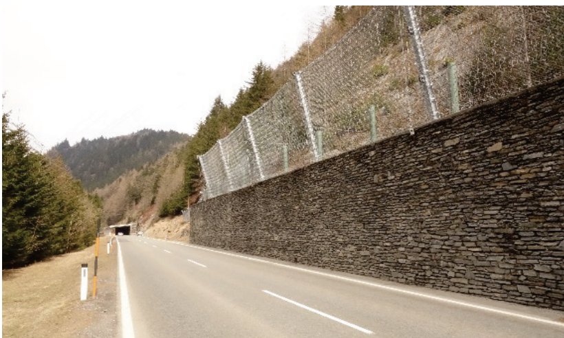
Abbildung 9: Das Lichtraumprofil einer Straße sollte von der Auslenkung des Netzes im Lastfall keinesfalls durchdrungen werden.
