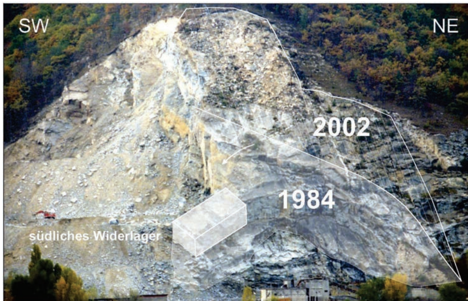
Abbildung 4: Felssturz am 4.10.1984 und beim Ereignis 2002 abgeglittene Felsmassen.
