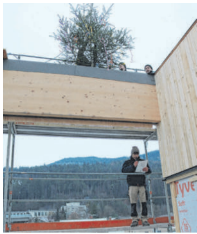
Nach rund zwölf Monaten Bauzeit ist der Schulneubau unter Dach.
