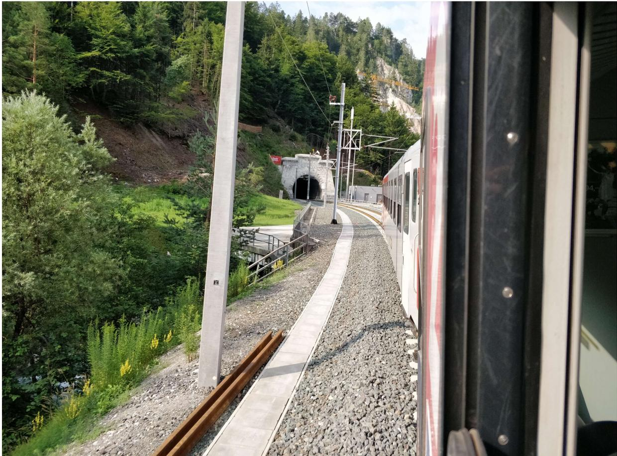
Abbildung 1.4: Zufahrt zum Karawankentunnel aus dem Norden nach dem Rückbau auf ein Gleis
