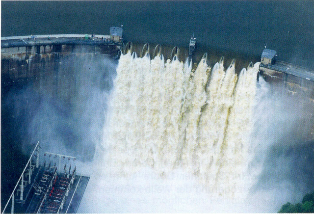
Abb.2. Klappenüberfall an der Sperre Ottenstein beim Hochwasser August 2002 (Foto: Österr. Bundesheer).
