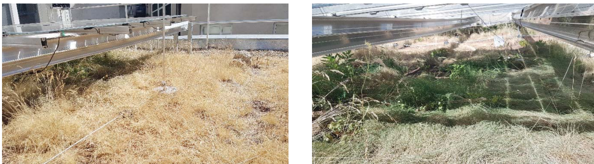
Abb. 58: Vegetation auf der freien Dachfläche (links) und unter den PV-Modulen (rechts) während einer Hitzeperiode.
