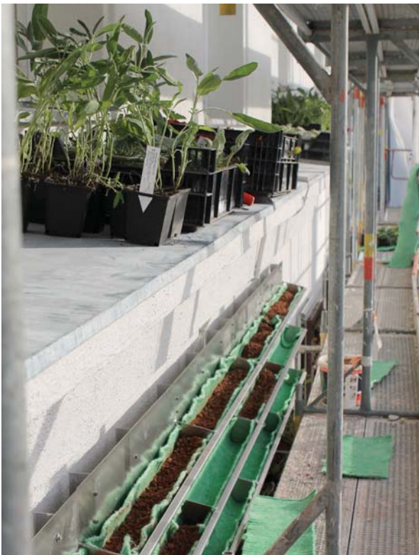
Abb. 5: Bepflanzung der Außenfassade mit Gerüst.
