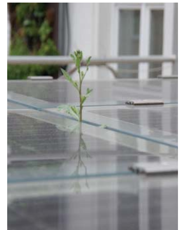
Abb. 45: PV-Module unbedingt vor Verschattung freihalten!
