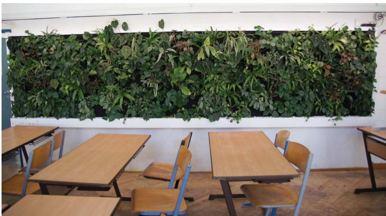
Abb. 14: Vliessystem im Klassenraum.
