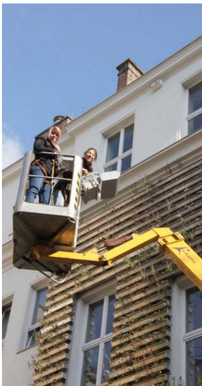
Abb. 29: Pflege der Grünfassade mit dem Hubsteiger.
