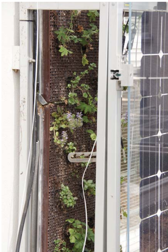
Abb. 46: Kombination von Grünfassade und transluzentem Photovoltaikmodul.
