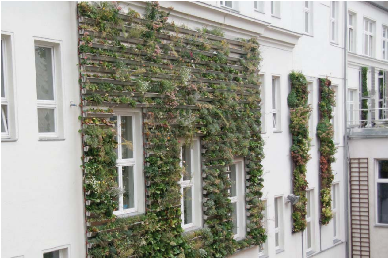
Abb. 21: unterschiedliche Fassadenbegrünungssysteme im Innenhof.
