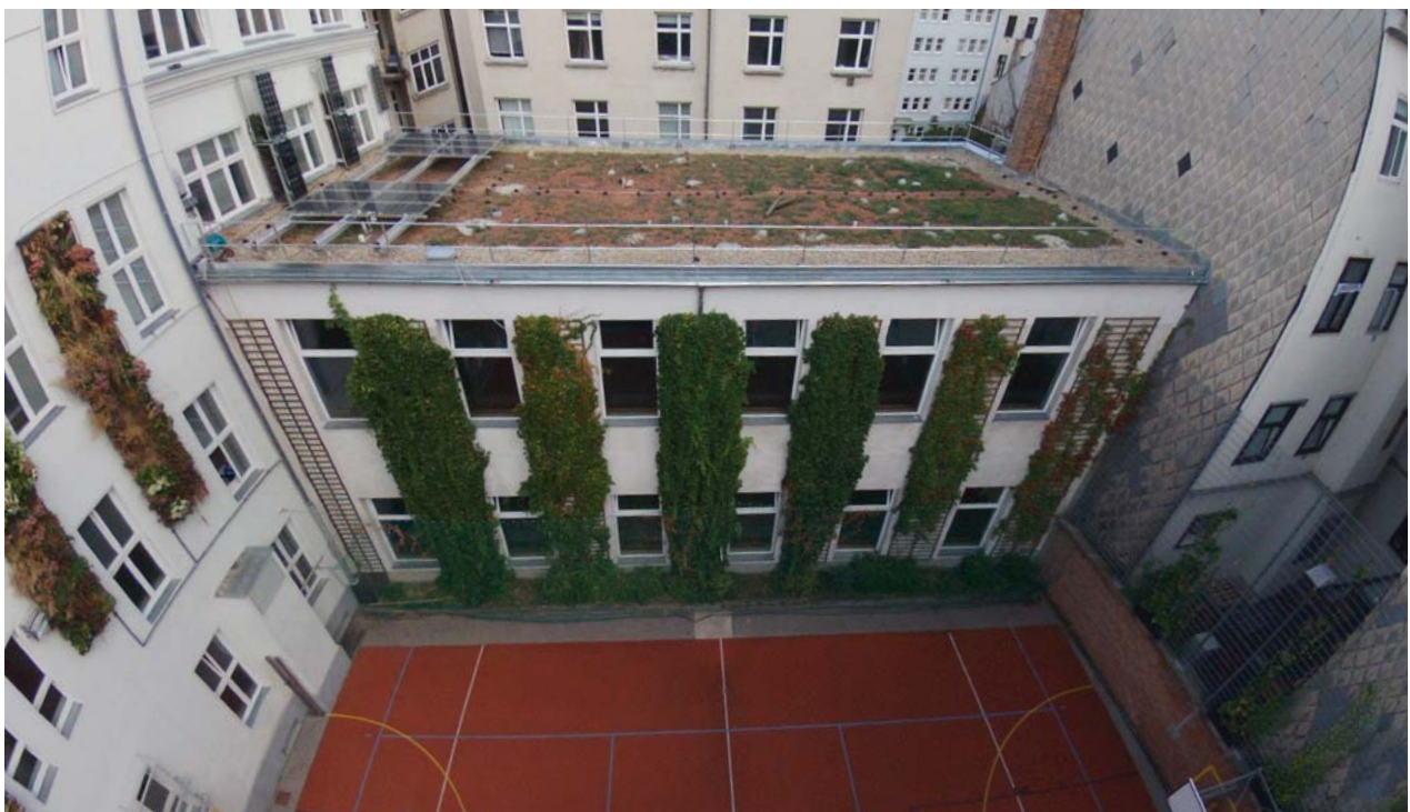
Abb. 1: Dachbegrünung mit vertikaler und horizontaler Photovoltaik und Innenhof mit verschiedenen Arten der Fassadenbegrünung.
