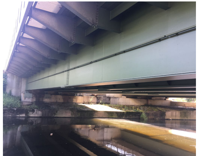
Bild 2: Stahl-Eisenbahnbrücke im österreichischen Bestandsnetz
