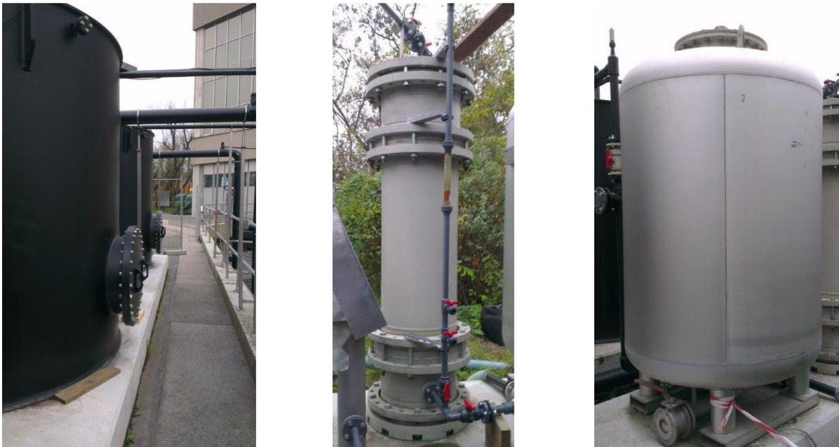
Abbildung 12: Ozon-Nachklingbehälter, Anthrazitfilter und Aktivkohle-Druckfilter (nachgeschaltet), von links nach rechts
