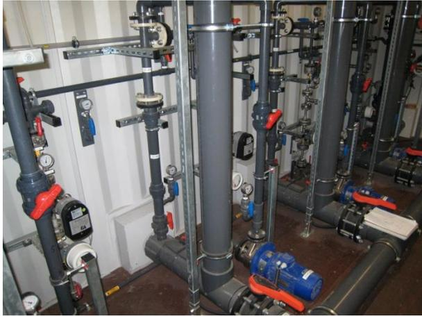
Abbildung 10: Rohrleitungsführung im Verrohrungscontainer mit den 4 Strängen, welche zu den Ozon-Reaktoren führen
