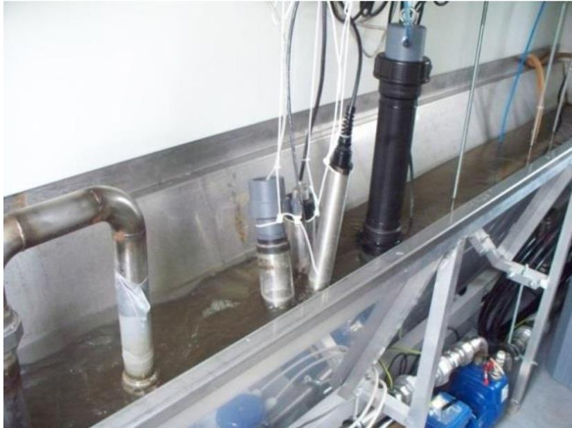
Abbildung 14: Messwanne im Messcontainer mit installierten Online-Sonden (Messstelle „IN“)
