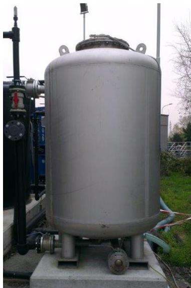
Abbildung 13: Aktivkohle-Druckfilter im Stand-Alone-Betrieb
