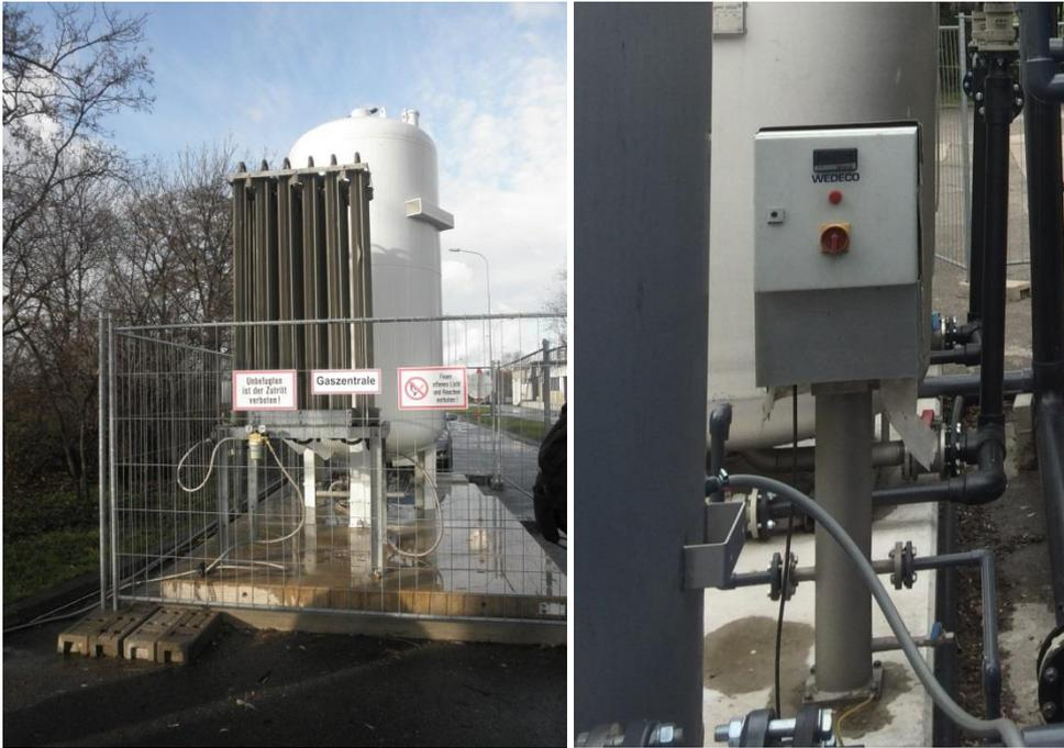
Abbildung 9: links: Sauerstoffanlage, bestehend aus Sauerstoff-Behälter (im Hintergrund) und Sauerstoff-Verdampfer (im Vordergrund); rechts: Restozonvernichter
