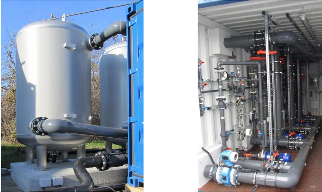
Abbildung 8: Ozonreaktor I (links) und assoziierte Verrohrung sowie Ozoneintragungssystem (rechts)
