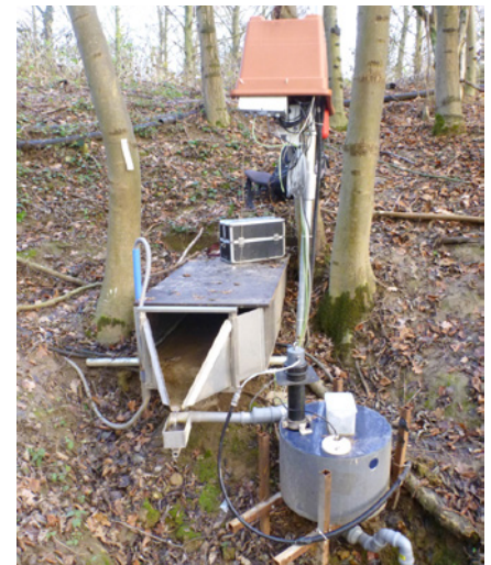
Abfluss- und Wassergütemessungen im HOAL
