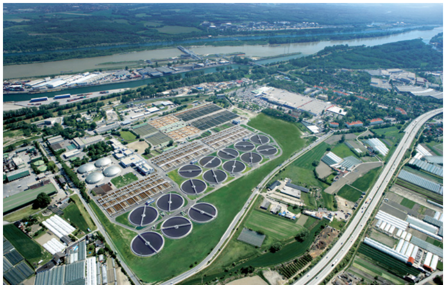
Die Hauptkläranlage Wien ist ausgelegt auf 4,0 Millionen Einwohnerwerte. © LBS ebswien
