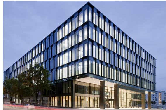
Bürogebäude ICADE Premier Haus, München
