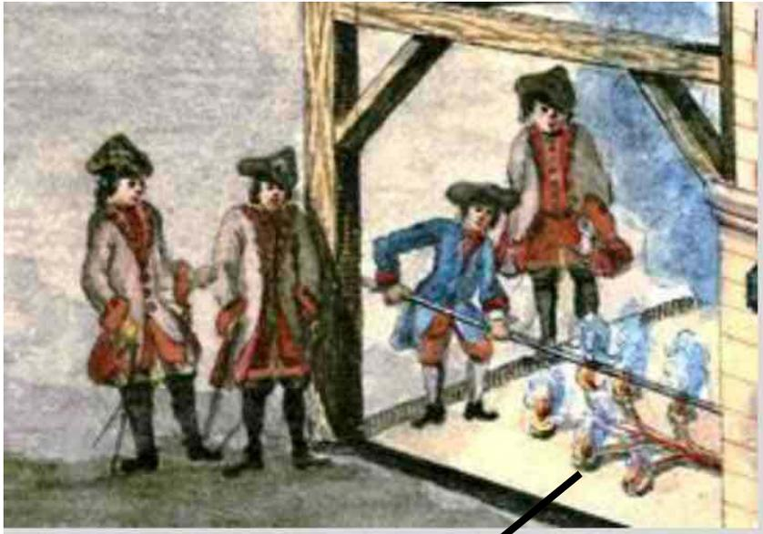
Am Ausgang der Gußpfanne wird das flüssige Metall in die Gußformen gefüllt, welche sich in Gruben hinter dem Schmelzofen befinden.
