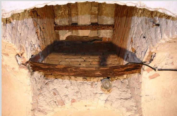
Links KG3, Gang als Teil des Belüftungssystems. Rechts KG6, Schacht mit Rost der ehem. Befeuerungsstelle, 1823.
