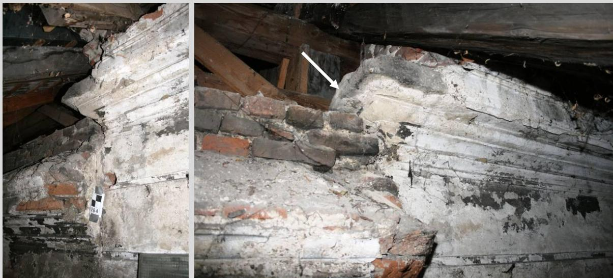
Übergang des barocken Dachgesimses des Osttrakts zum sekundär aufgezonten Dachgesims des Südtrakts. Der Pfeil markiert den weiteren Verlauf des Gesimses des Osttrakts nach Norden.
