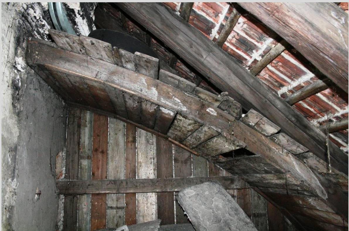
Dach eines ehem. Portalvorbaus an der Südfassade des Osttrakts, dendrochronologisch mit 1769 datiert, heute im Dachraum von EG1.
