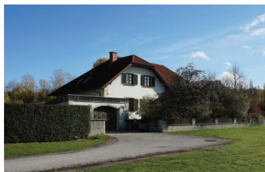
Abb. 2.43: Gefährdetes Einfamilienhaus in Walbersdorf. Quelle: Güler 2021.
