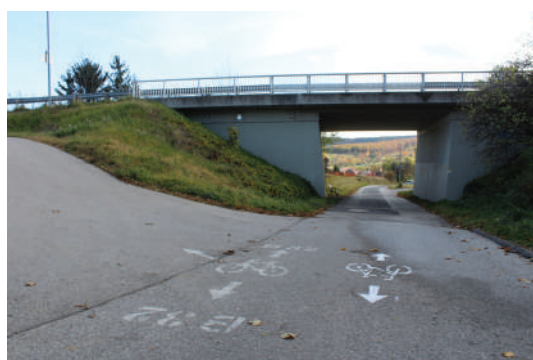
Abb. 8.55: Unterführung Blickrichtung Walbersdorf. Quelle: eigene Aufnahme
