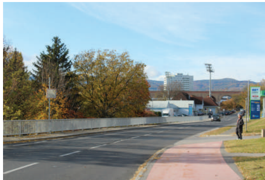
Abb. 8.53: Michael Koch-Straße Blickrichtung Zentrum. Quelle: eigene Aufnahme
