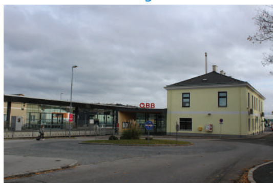
Abb. 8.5: Bahnhof Mattersburg Gebäude. Quelle: eigene Aufnahme
