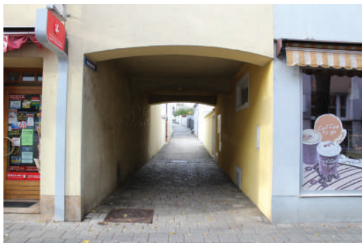
Abb. 8.19: Matschakerhof. Quelle: eigene Aufnahme
