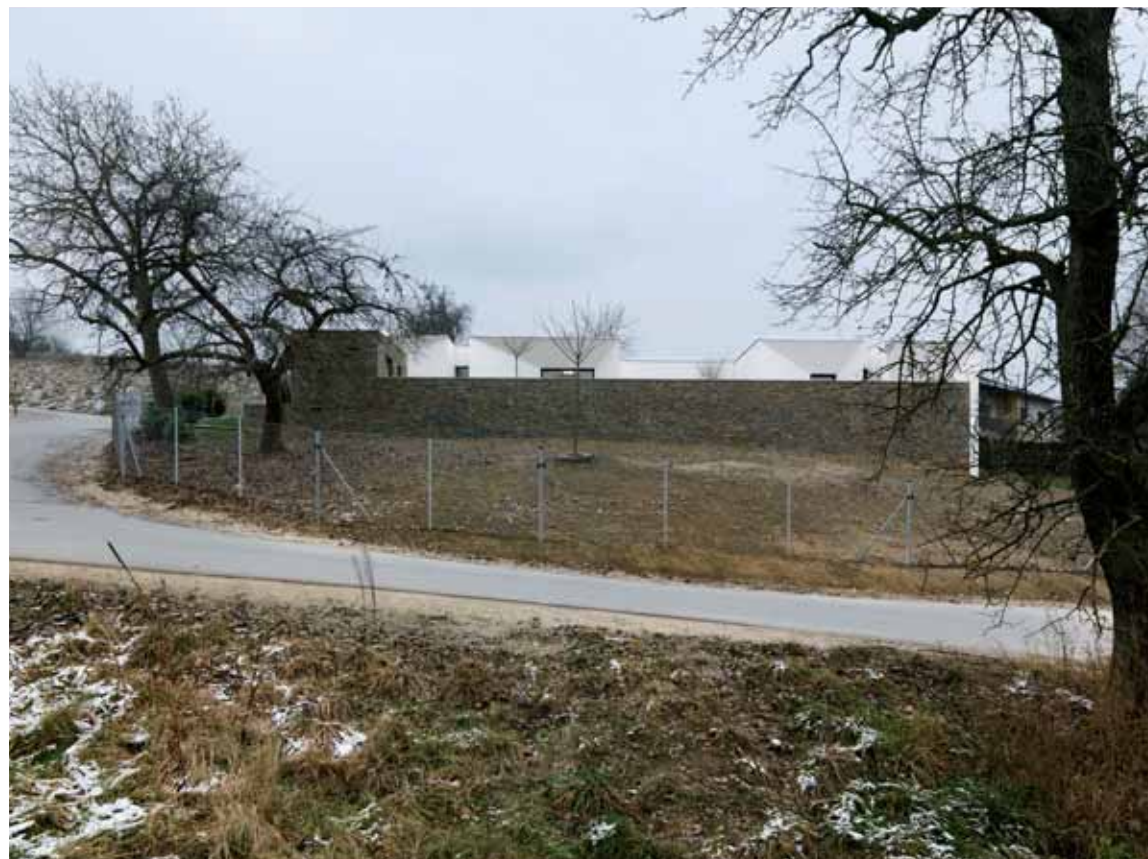
Hertl Architekten Egger Haus, Oberösterreich, 2009 Foto: Paul Ott
