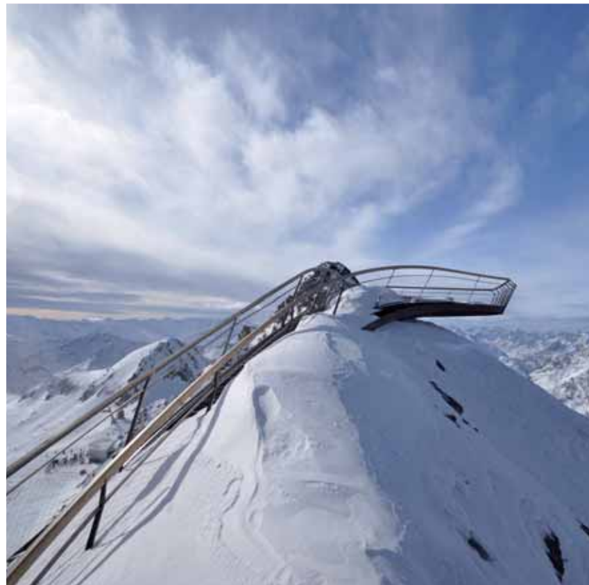
LAAC Architekten Gipfelplattform „Top of Tyrol“, Tirol, 2008 Foto: LAAC
