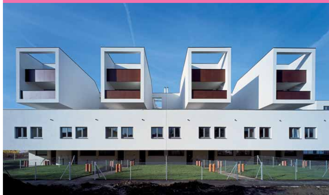
Walter Stelzhammer Wohnbau Orasteig, Bauteil A1, Wien, 2009 Foto: Rupert Steiner
