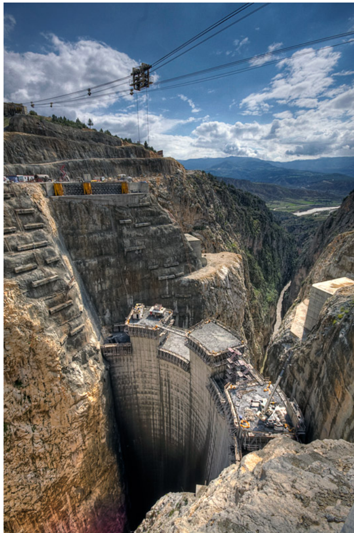
Errichtung der Sperre Ermenek
