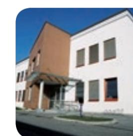
Der neue mehrgeschoßige Baukörper ist mit einer Länge von rund 58,4 m, einer Breite von 34,7 m und einer Höhe von 13,7 m konzipiert und vollflächig unterkellert. Er gliedert sich in den straßenseitigen „Büro-Labortrakt“, mit Büro- und Laborräumen sowie einer Werkstatt und der dahinterliegenden neuen Versuchshalle.
