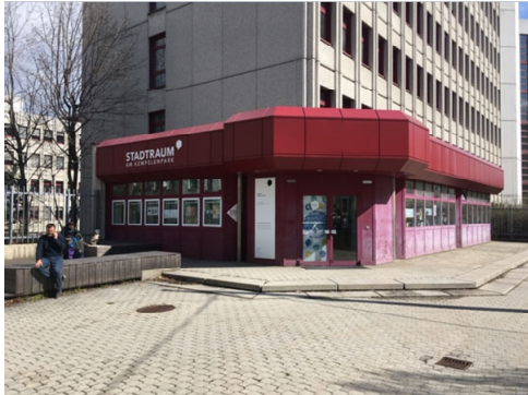
Arbeiten vor Ort Stadtraum am Kempelenpark
