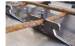
Vernageltes Puzzle Strip Schublech mit Flächenbewehrung
