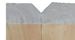
Resultierende v-förmige Fuge zwischen aneinander gereihten Vollholzbalken
