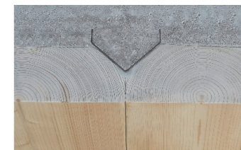
Resultierende v-förmige Fuge zwischen aneinander gereihten Vollholzbalken, vernageltem Puzzle Strip Schublech und bewehrtem Verbundbeton
