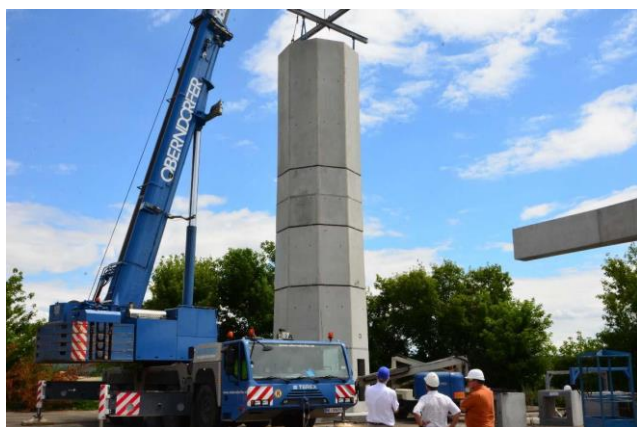
Prototyp – errichtet mit dem neuen Bauverfahren
